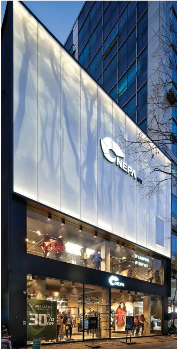
Fashion NEPA | Sistema de fachada única de 16 mm da Danpal® Arquitetura: Mark Fran/de plus
