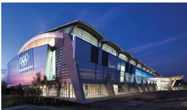
Olimpíadas de Inverno 2010, Vancouver, Canadá | Sistema de fachada única de 16 mm da Danpal® | Arquitetura: ING
